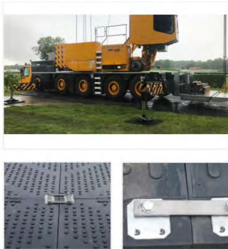
Figure 18 : exemple de plaques Envhyro Trak utilisées pour stabiliser les engins.
