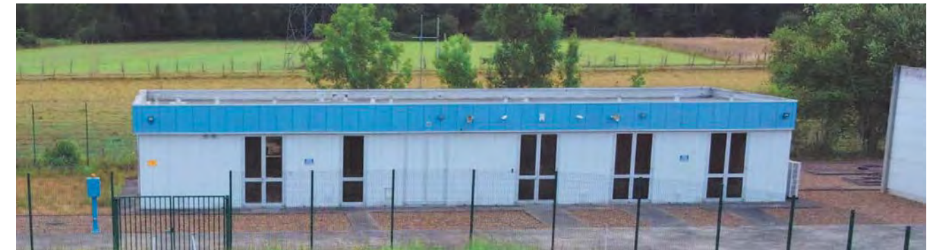
Bâtiment technique du poste électrique situé au Sud-Est du site du projet Source : PHOTOSOL
