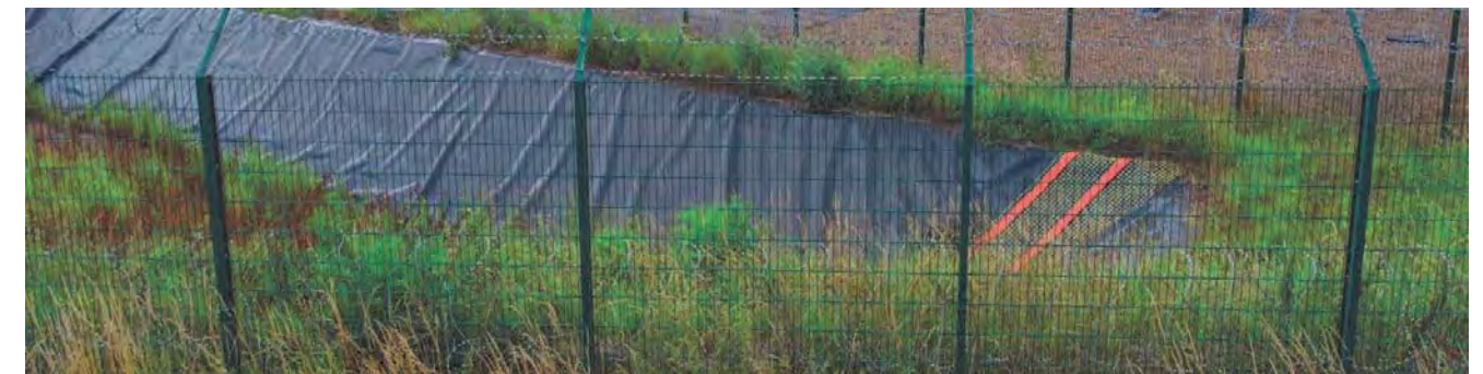
Vue en direction des clôtures du poste électrique, présentes aux abords du site du projet Source : PHOTOSOL
